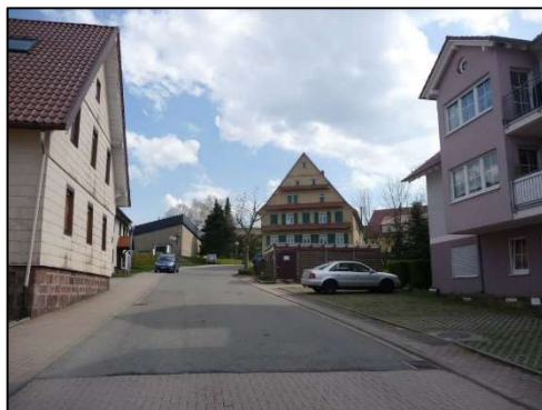
Abbildung 3: Blick von Norden Richtung Obere Bergstraße
